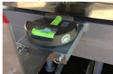
Bild 8: Einmessen vom Lager mittels 2-Achsen-Wasserwaage.
