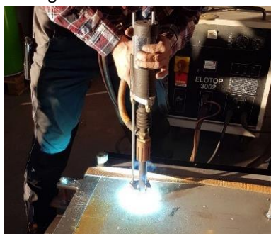
Bild 3: Anschweißen der Kopfbolzendübel mittels Bolzenschussgerät.
