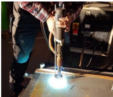
Bild 2: Anschweißen der Kopfbolzendübel mittels Bolzenschussgerät.
