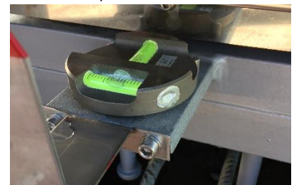
Bild 8: Einmessen vom Lager mittels 2-Achsen-Wasserwaage.
